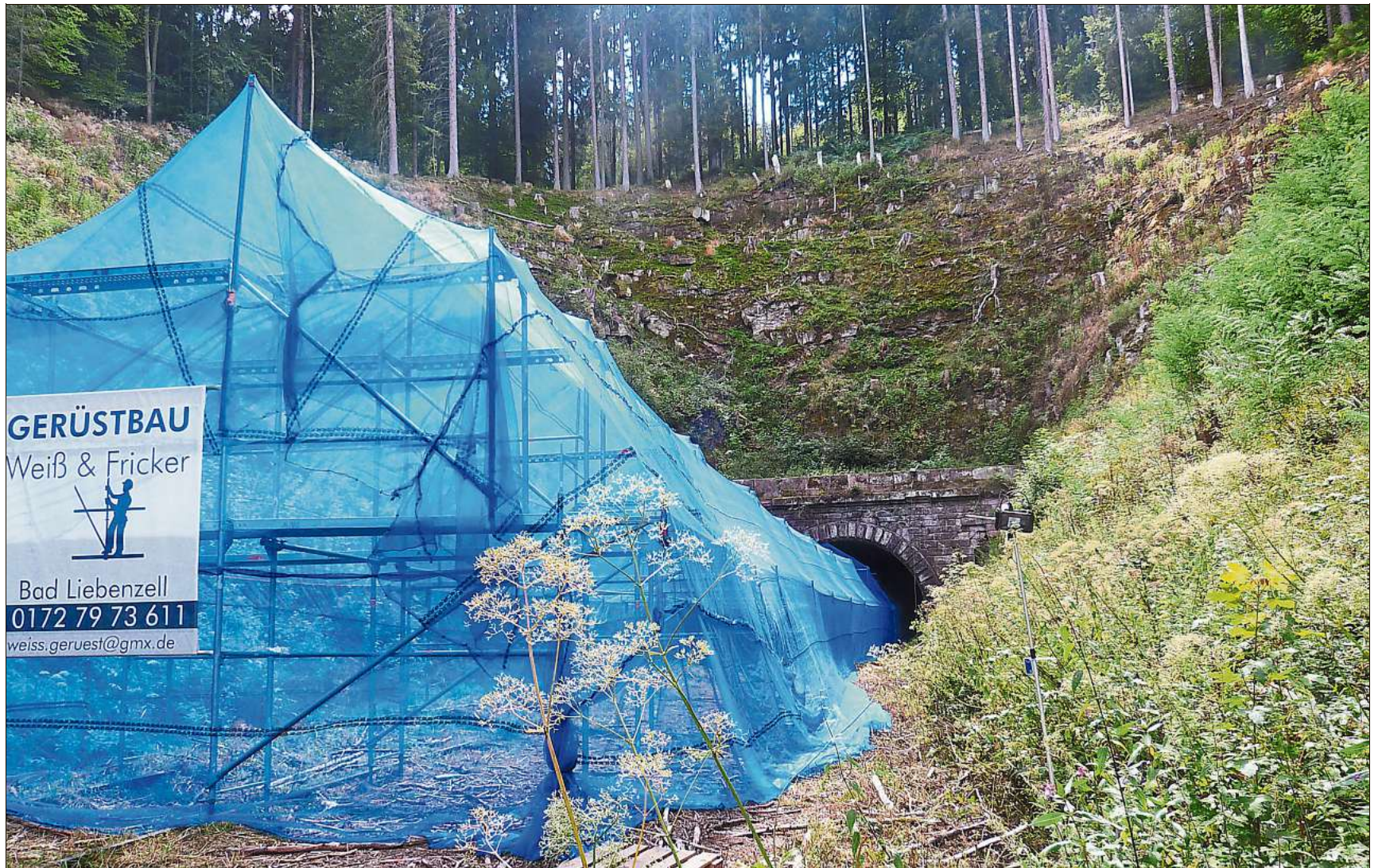
Eine provisorische Konstruktion vor – und im – Hirsauer Tunnel soll die »Kammerlösung« simulieren.
