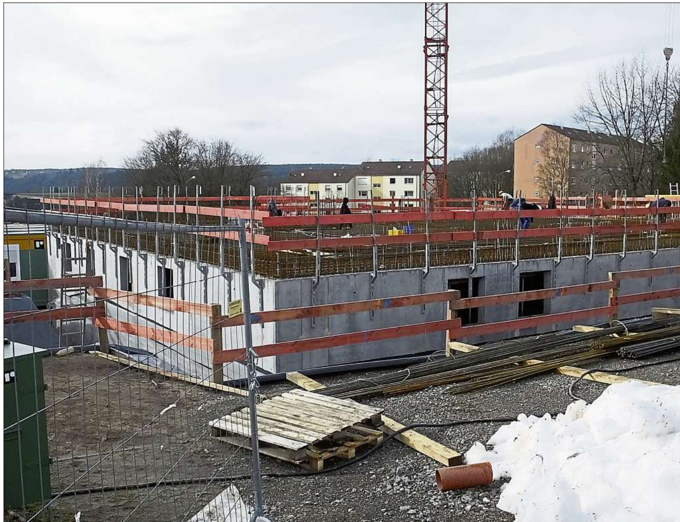
Der Baufortschritt an der entstehenden Seniorenresidenz in Heumaden ist deutlich sichtbar.
