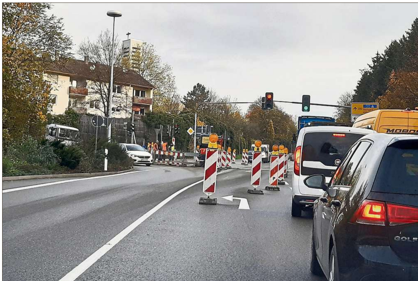
Die Abbiegespur nach Heumaden ist derzeit teilweise gesperrt.
