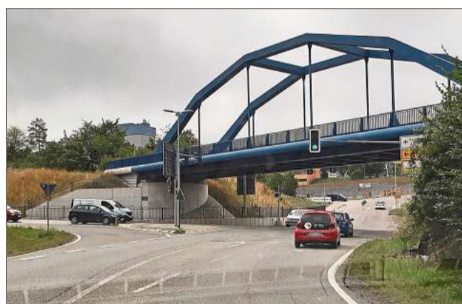
Noch gibt es sie, die Linksabbiegespur aus der Breite Heerstraße. Diese soll gestrichen werden. Foto: Klormann
