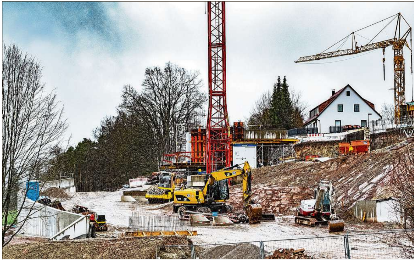
Auf der Baustelle des Parkhauses bei Heumaden tut sich derzeit einiges.
