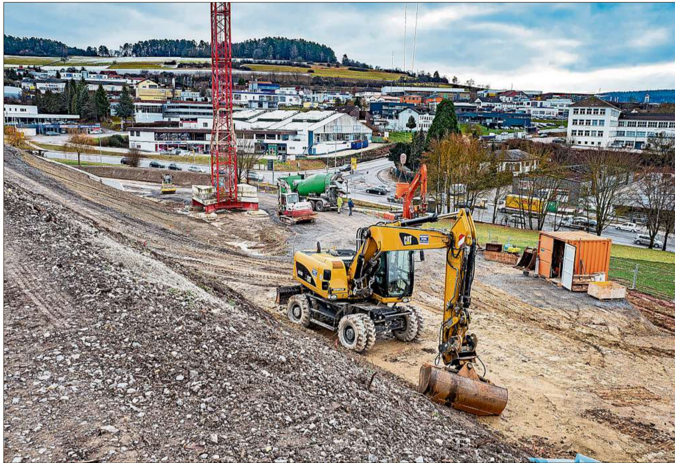
Die Arbeiten wurden nach der Winterpause am Montag wieder aufgenommen.
