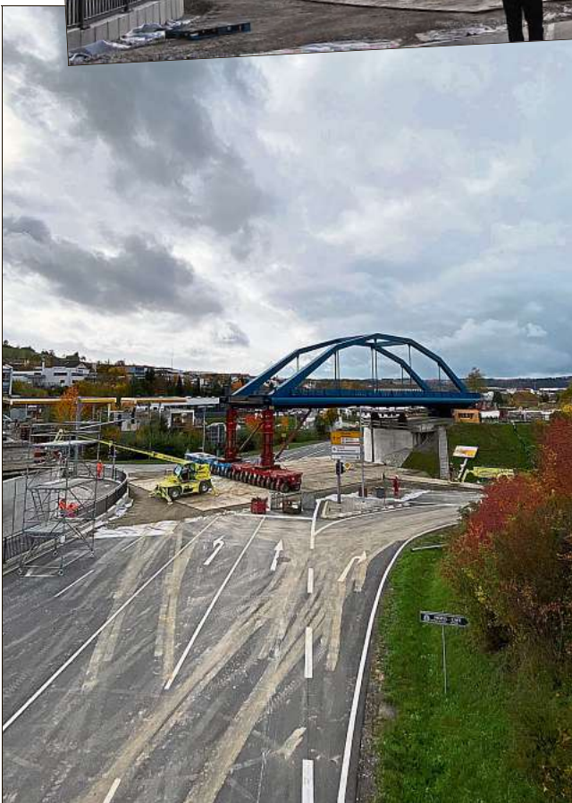
Für den Einschub wurde die Straße gesperrt. Fotos: Landratsamt
