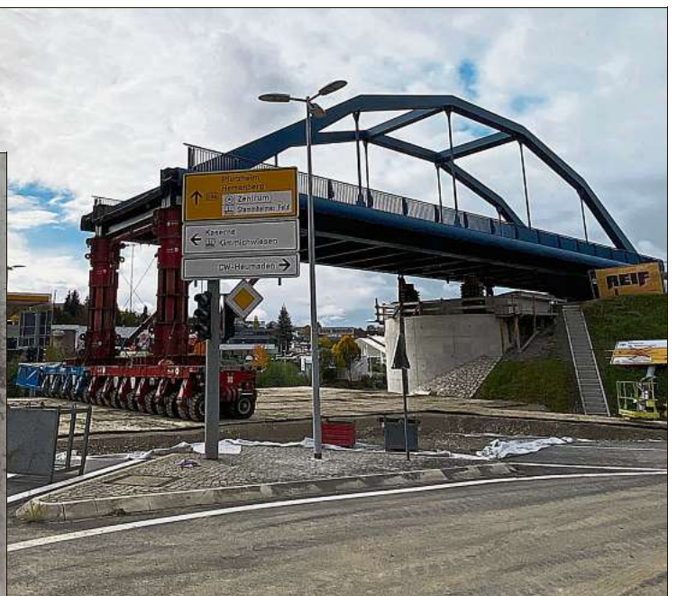
Die 45 Meter lange, rund 300 Tonnen schwere Brücke wird mittels Rollen an seinen künftigen Bestimmungsort gebracht.
