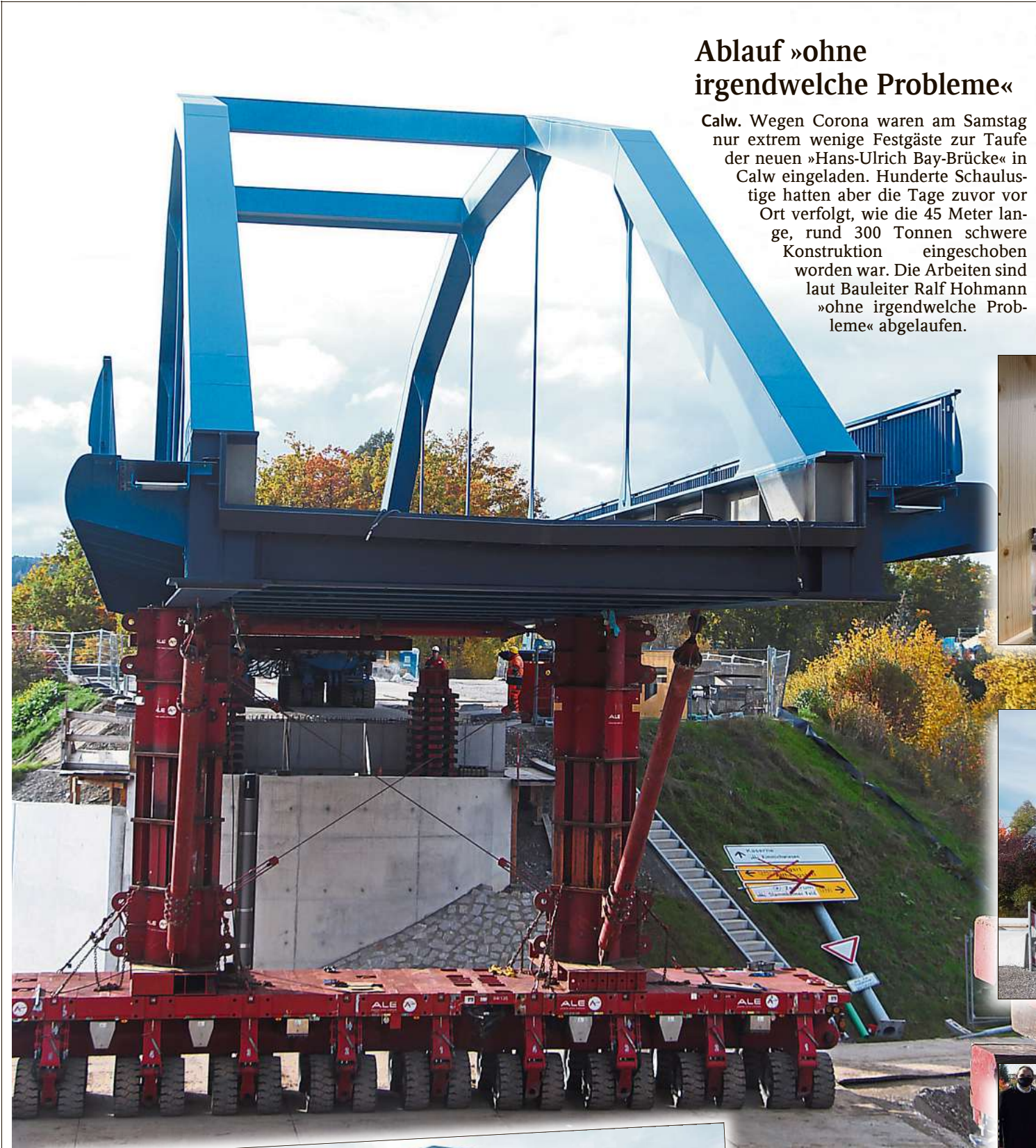
Zentimeter für Zentimeter schob sich das Konstrukt über die Straße bis hin zum Widerlager auf der anderen Seite. Foto: Buck
