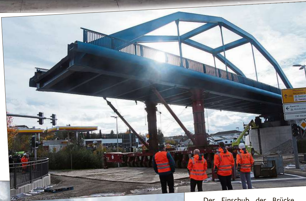
Der Einschub der Brücke ging schneller voran als geplant. Foto: Buck
