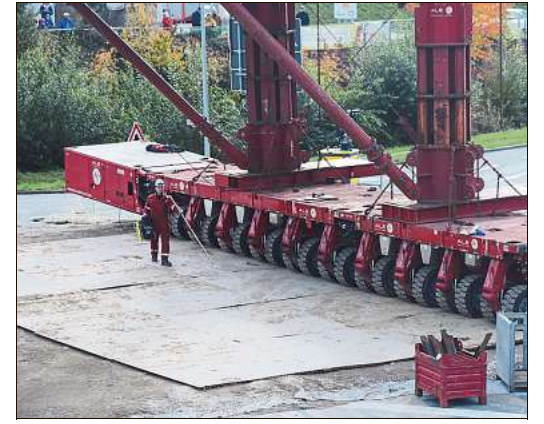
Mit riesigen Rollen wurde die Brücke über die Straße transportiert. Foto: Buck
