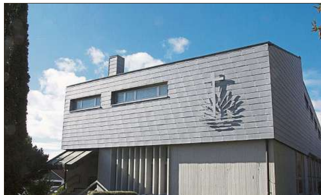
Das bisherige Gebäude der Neuapostolischen Kirche soll abgerissen werden. Foto: Menzler
