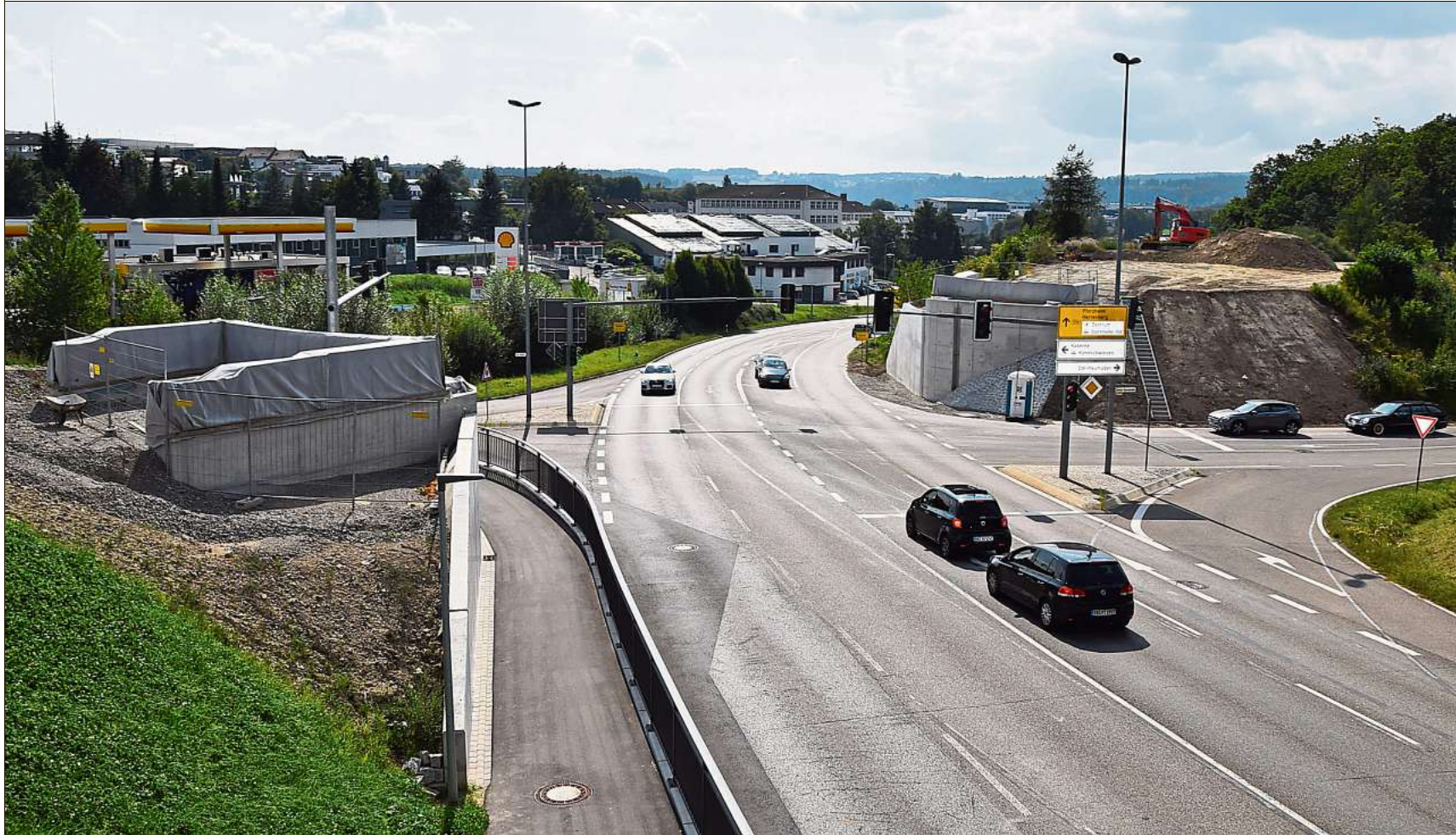
Der Verkehr auf der Bundesstraße 295 kann wieder ungehindert fließen.
