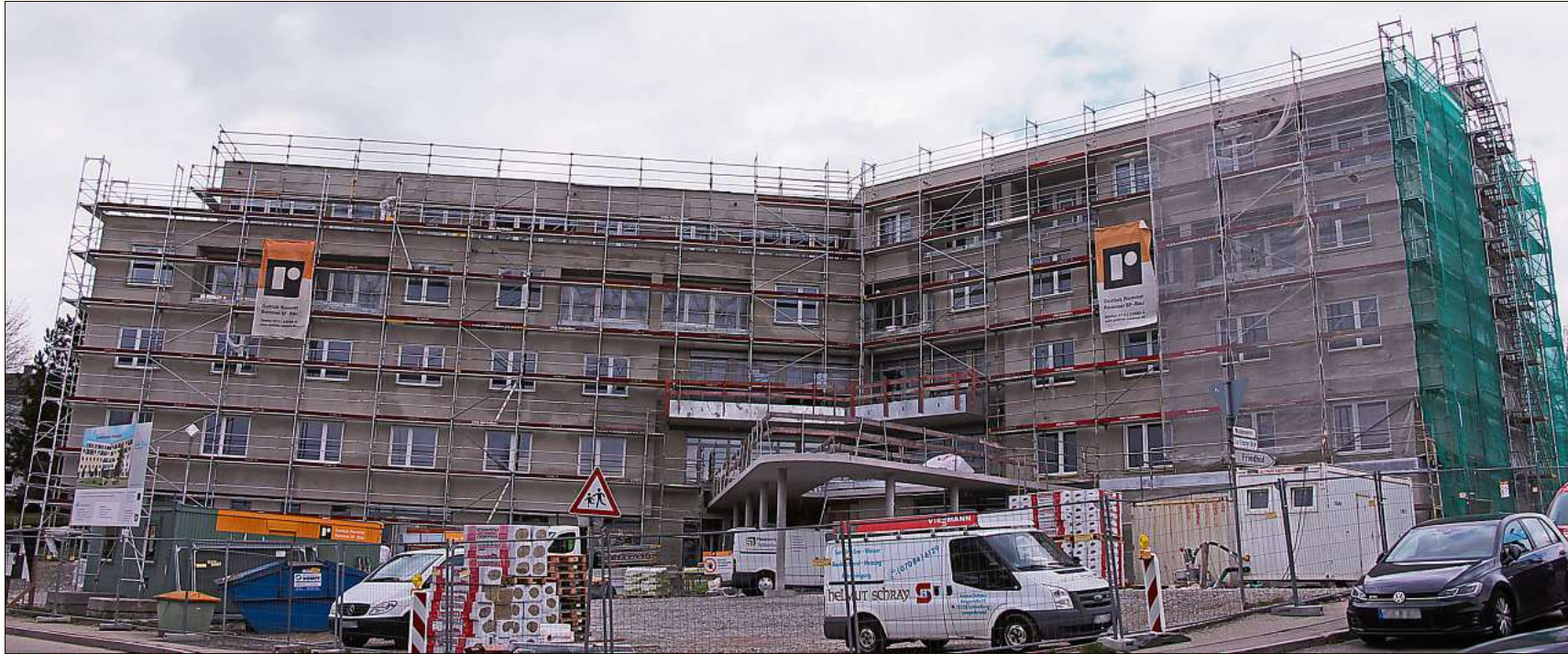
Der Bau inmitten von Calw-Heumaden wächst und gedeiht – für den 21. September ist ein Tag der offenen Tür geplant.
