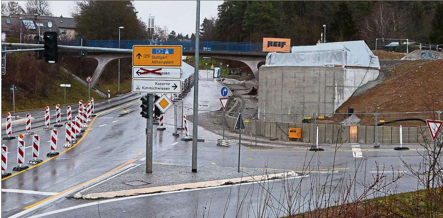
Das Widerlager auf der Ost-Seite ist bereits fertig, das gegenüberliegende wird noch dieses Jahr gebaut.
