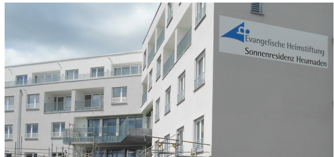
Die Sonnenresidenz Heumaden ist kurz vor der Fertigstellung (Foto: Susanne Fetzer)
